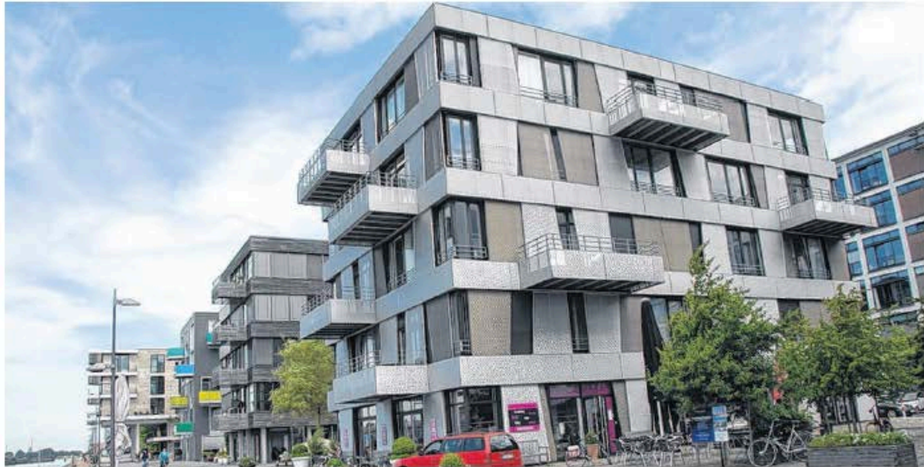
Auf zwei Ebenen des Gebäudes am Port Vier entstehen derzeit barrierefreie Büroräume. Dort können sich Kleinunternehmen einmieten und miteinander vernetzen. Foto: Kristina Wiede
